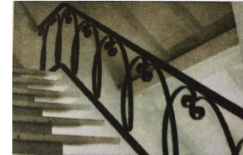
Escalier montant au clocher
