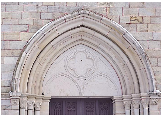
Portail central au motif tréflé quadrilobé
