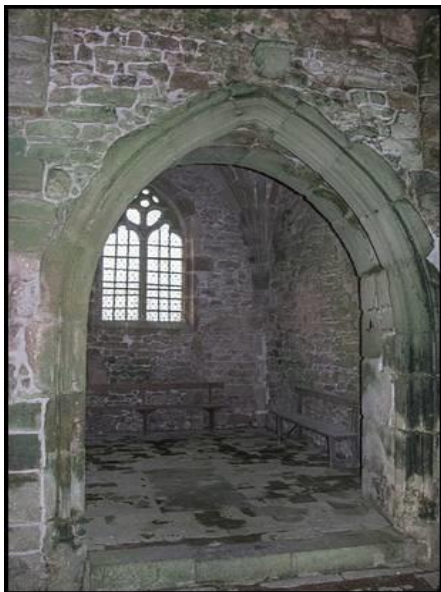
Chapelle gothique (entrée en arc brisé)
