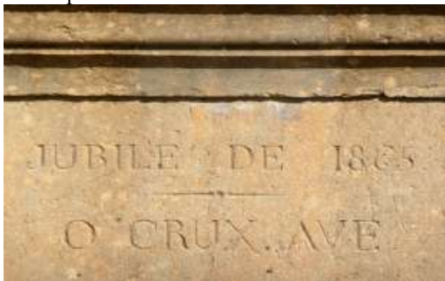
5 bis. Croix nettoyée par hydrogommage par l'Entreprise Girardon de Charolles en 2014.
