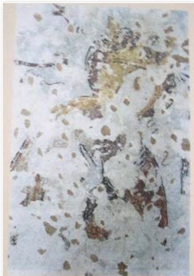
Cliché provenant du rapport de restauration d'Anne Féton, 1992, archives SMBS : Abside, cul-de-four, scène du couronnement de la Vierge, détail de la Vierge.
