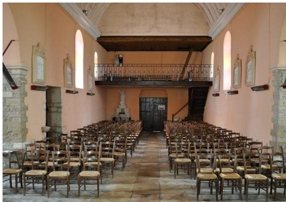
Nef romane et petites baies ébrasées en réemploi sur la tribune
