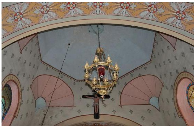
Coupole octogonale sur trompes romane
